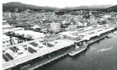
新設なった気仙沼市魚市場。全長850mに及ぶ（提供：気仙沼市）
