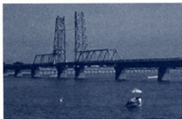
筑後川下流にかかる昇開橋。1935年、国鉄佐賀線の鉄橋として建設されたもので、廃線後は歩道橋として活用されている(重要文化財・機械遺産に指定)。
