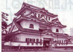
小田原市内に建つういろう本店。唐破風造りの城郭風の建物は街のシンボルとなっている。
