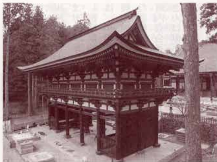
再建工事中の「中門」
