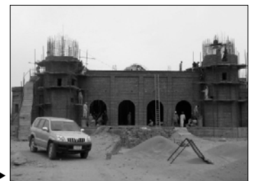
◀マドラサの屋根うち。住民総動員で3月19日に完了（2009年3月18日）
